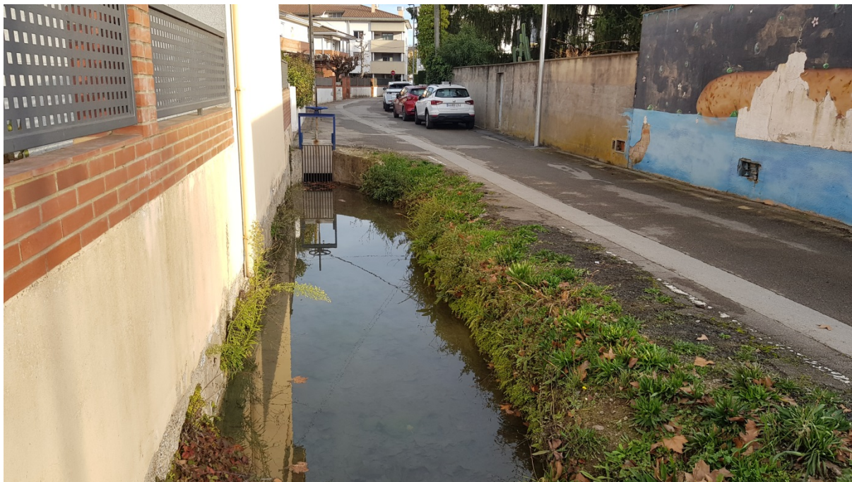
Imatge 8. Comporta existent, la nova s'instal·larà just aigües amunt
